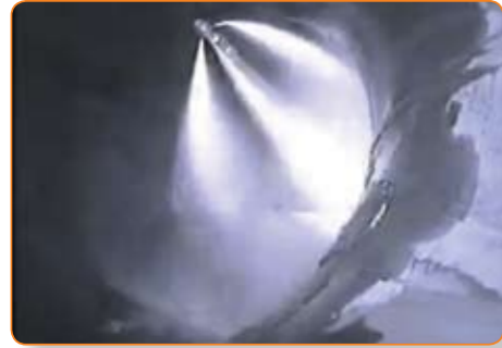
Работа ротационной гидрофрезы в полостях котла
