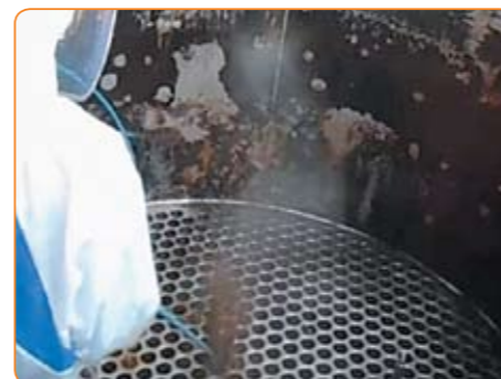
Гидродинамическая очистка технологического теплообменника
