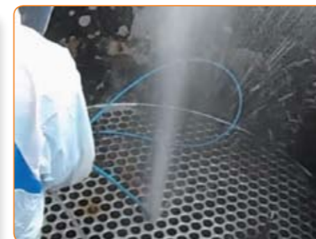
Гидродинамическая очистка технологического теплообменника
